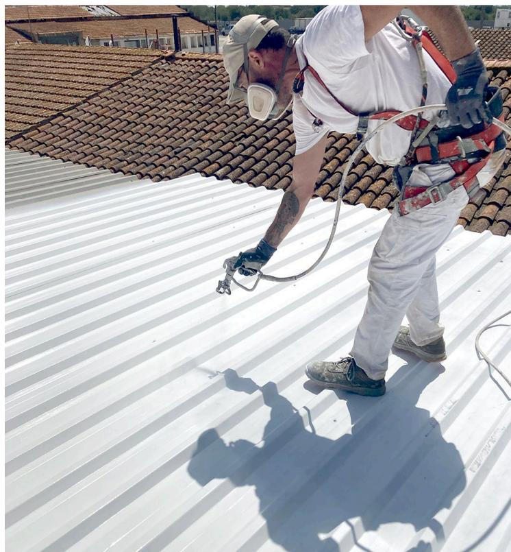
Aplicación del Escudo Térmico Total sobre la cubierta de un edificio, de forma sencilla
