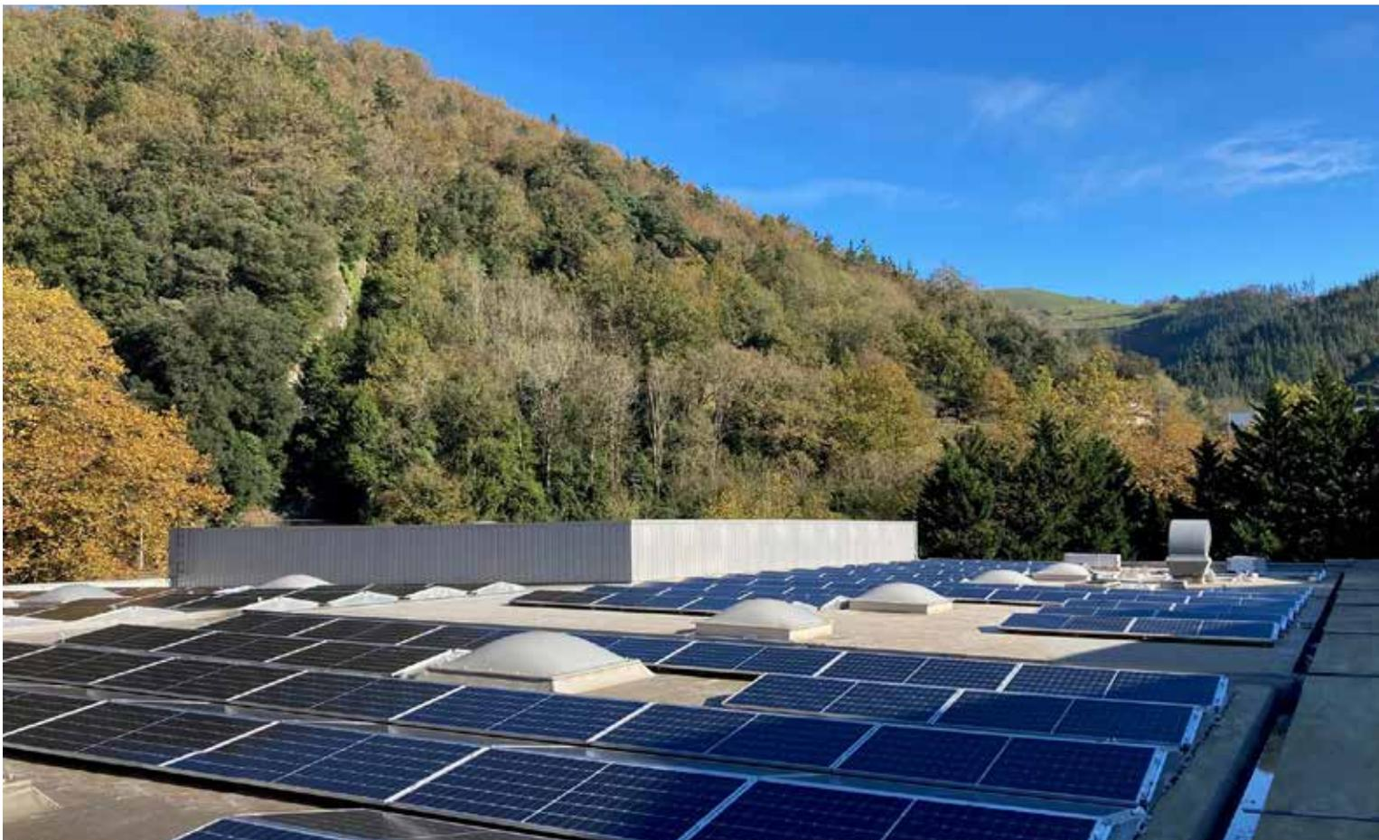
Los 800 paneles solares para autoconsumo en la planta de Elgoibar generan 490.000KWh/año, lo que equivale al consumo anual de 150 hogares.
