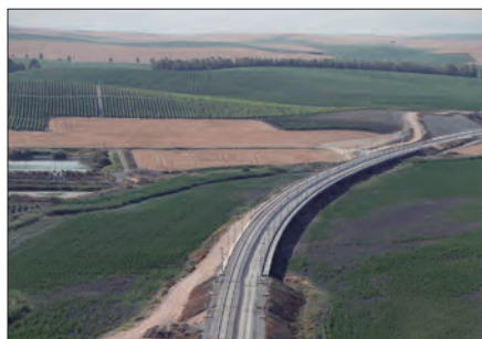
LAV Sevilla-Cádiz. Viaducto en zona de marismas
