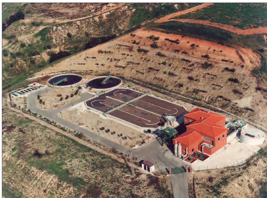
EDAR Puente Genil. Córdoba
