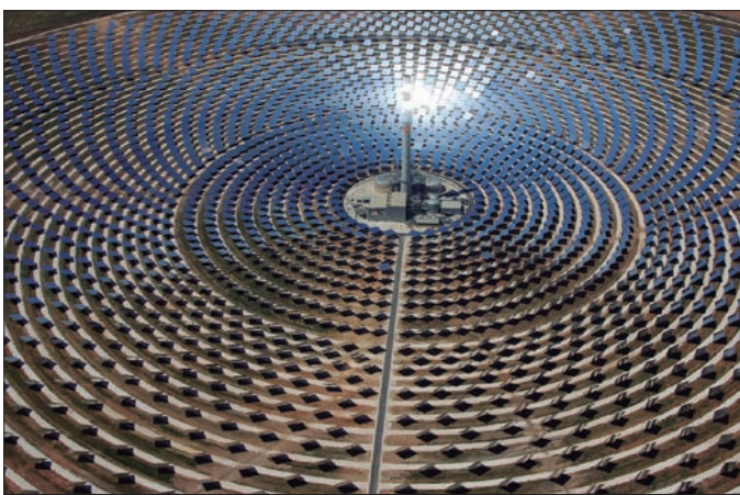
Planta de energía solar por concentración Gemasolar, con tecnología de SENER
