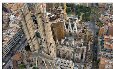
Túnel Sants-Sagrera, alta velocidad (Barcelona, España)
