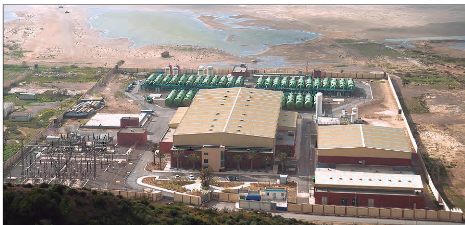
Desaladora de Mostaganem, Argelia
